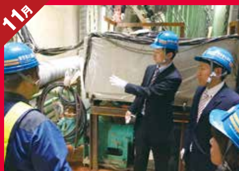
11月 有明給水所（東京都）工事現場視察
